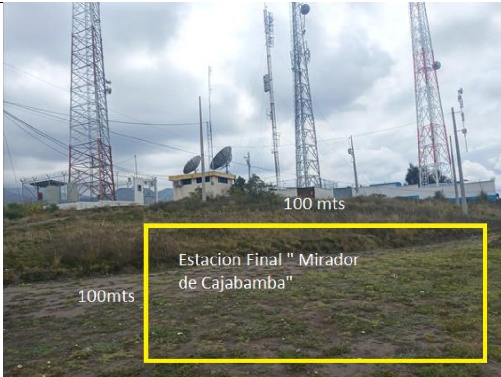
Fotografía: Construcción Estación Final (1000m2).
