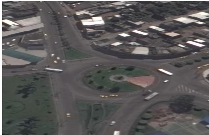
Intersección N o 6 Av. Abraham Calazacón y Av. Esmeraldas
