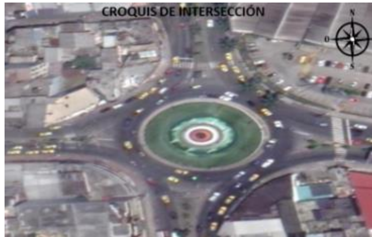
Intersección N o 5 Av. Quito y Av. Abraham Calazacón
