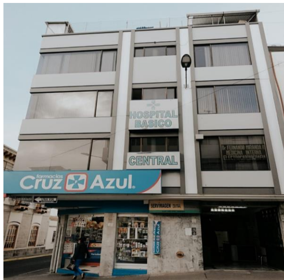
Figura 14-3: Hospital Básico Central, Calle Montalvo Realizado por: Villacís, Ruth, 2020
