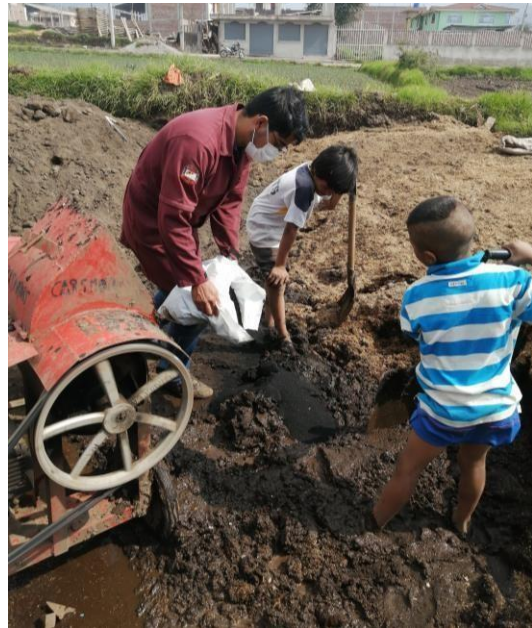
Fotografía 2. Homogenización del barro y los agregados.
