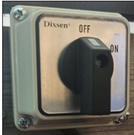
Figura 30-3: Instalación del interruptor principal
