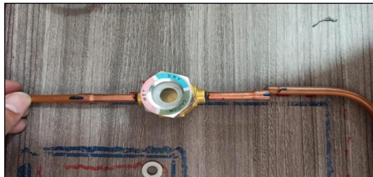
Figura 16-3: Conexión visor y cañería
