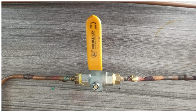
Figura 14-3: Válvula conectada la tubería de cobre
