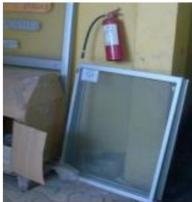
Figura 8-3: Insuficientes elementos de seguridad
