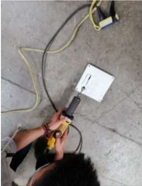
Figura 15-3: Proceso de corte para la instalación de los componentes del sistema
