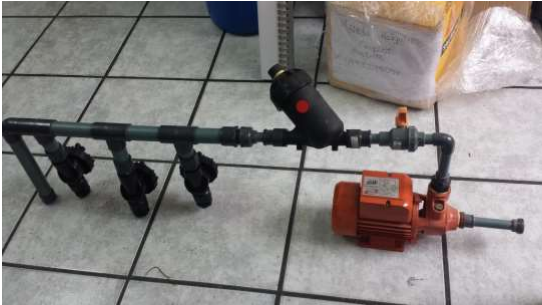
Figura 29-3: Sistema de riego en proceso de construcción
