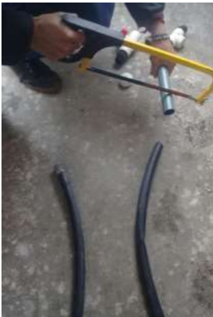
Figura 28-3: Corte de la tubería y armado del sistema
