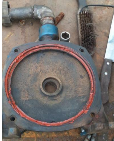
Figura 4-3. Hermetizado de tapa de bombas.
