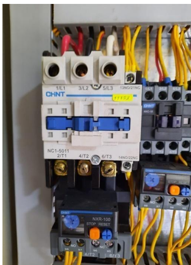
Figura 16-3. Contactor 50A.
