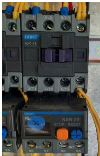
Figura 17-3. Contactor de 27A.
