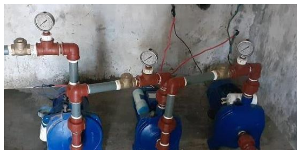
Figura 26-3. Conexión de manómetros.
