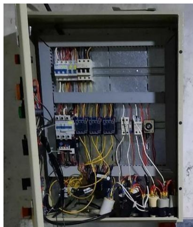
Figura 13-3. Conexión del tablero de control.
