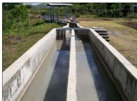
Figura 5-2: Canales de desarenadores
