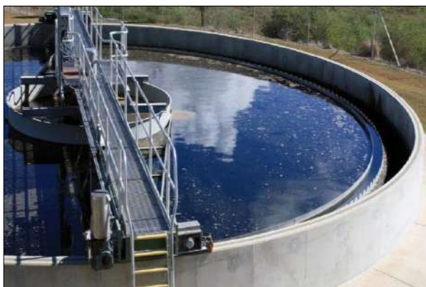
Figura 12-22-1: Procesos aerobios de aguas residuales
