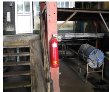
Figura 72: Falta de señalización de los extintores
