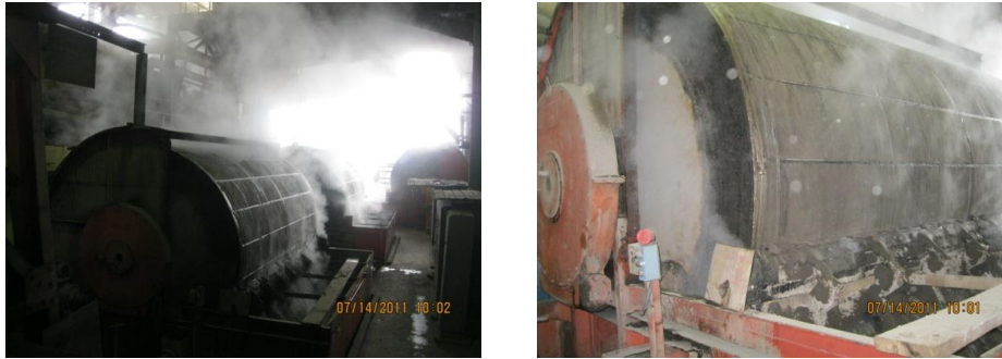
Figura 35: filtros de cachaza
