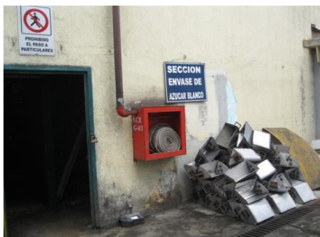
Figura 71: Manguera en mal estado
