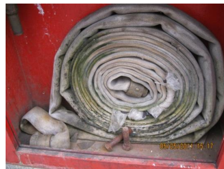
Figura 71: Manguera en mal estado
