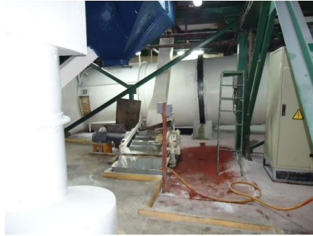
Figura 75: Obstáculos en el piso
