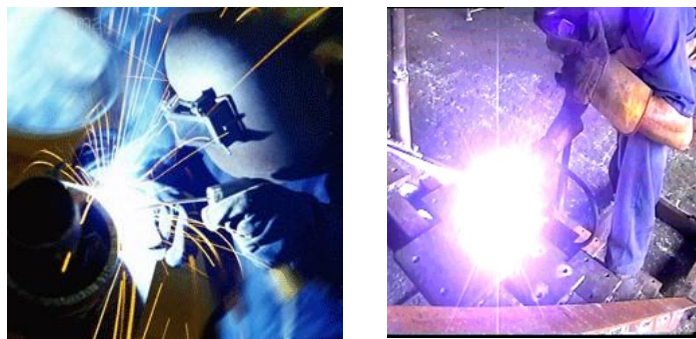
Figura 67: Gases en el proceso de soldadura.
