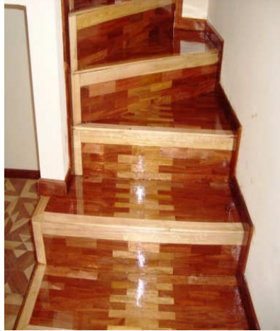
Figura 47 Escalera tipo Caracol.
