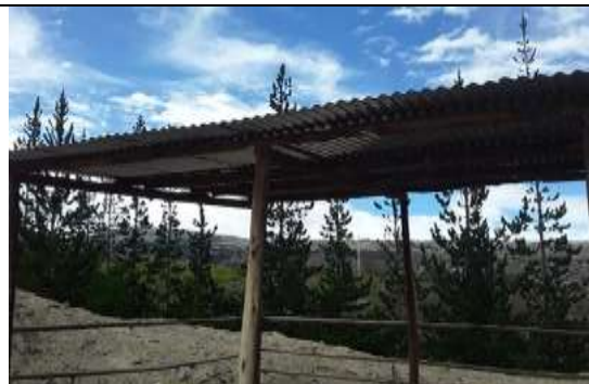
Construcción del techado.
