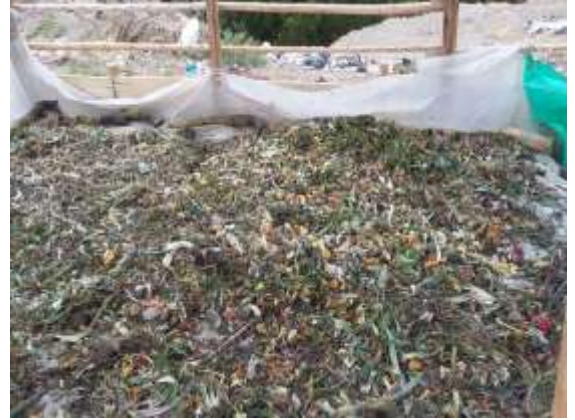
Acopio de residuos.
