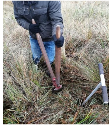
Limpieza del suelo
