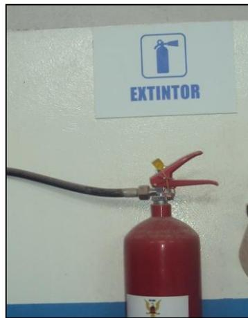
**Figura 22: Señalización incorrecta.**
