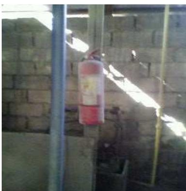
**Figura 3.3.10.1.a:** Extintor tipo PQS 1
