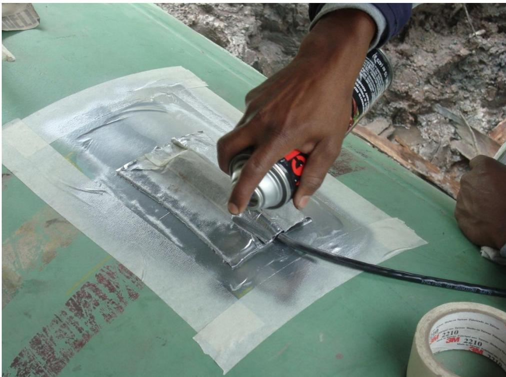
**Fig. 18.** Recubrimiento con pintura anticorrosiva
