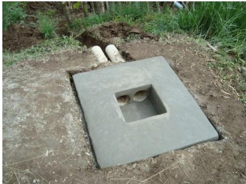
Se deberá construir una base de concreto en un sitio previamente definido y que nos proporcione las facilidades necesarias como para poder instalar en ella sin ningún tipo de inconvenientes los cables que llegarán a este punto desde los puntos de instalación de los strain gauges.
