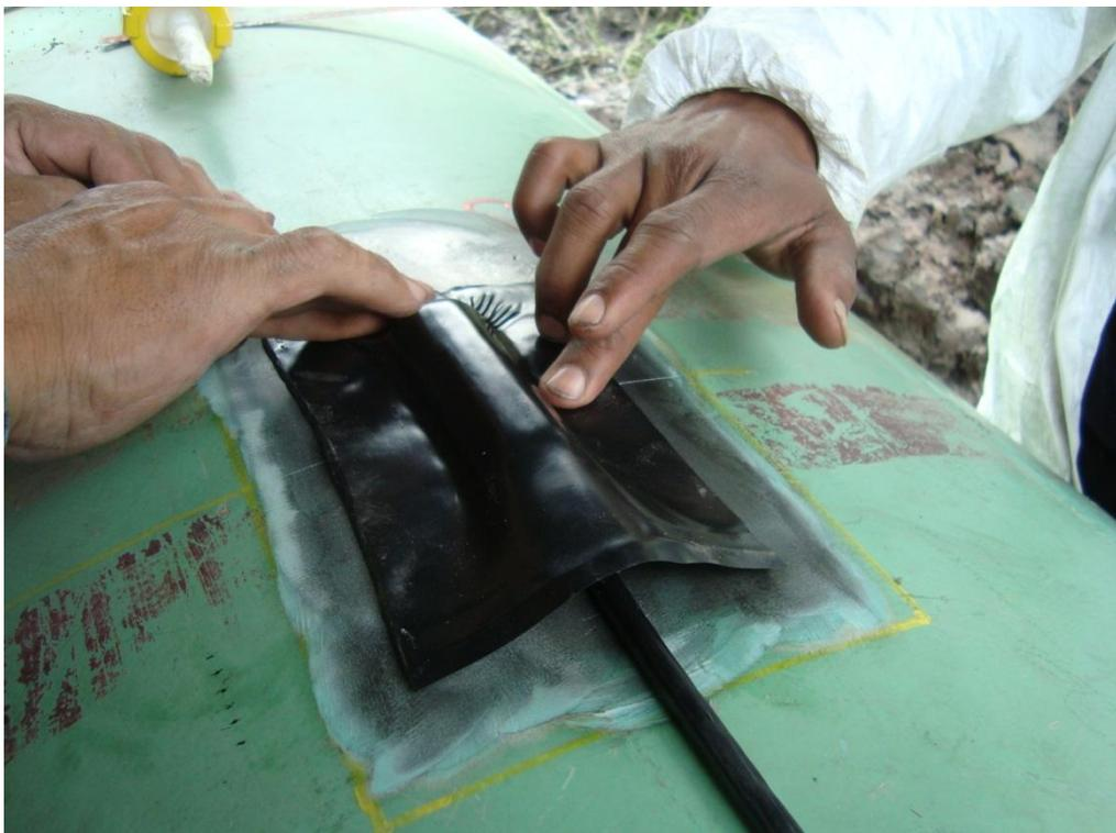
Fig. 17. Colocación del masticpad
