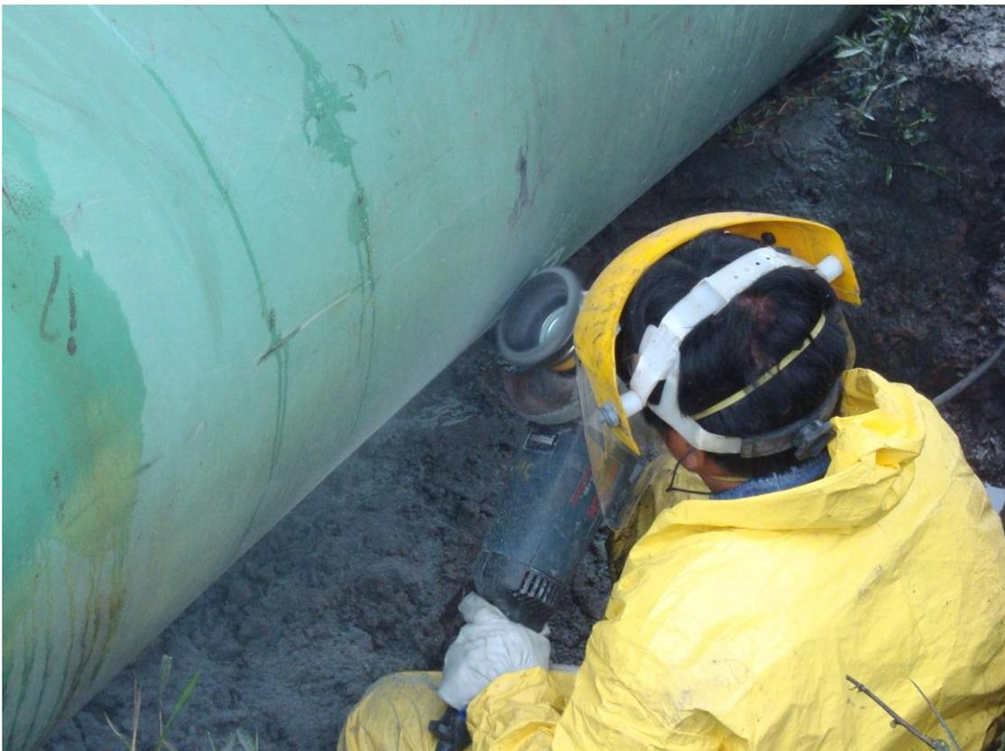
**Fig. 10.** Retiro del recubrimiento FBE
