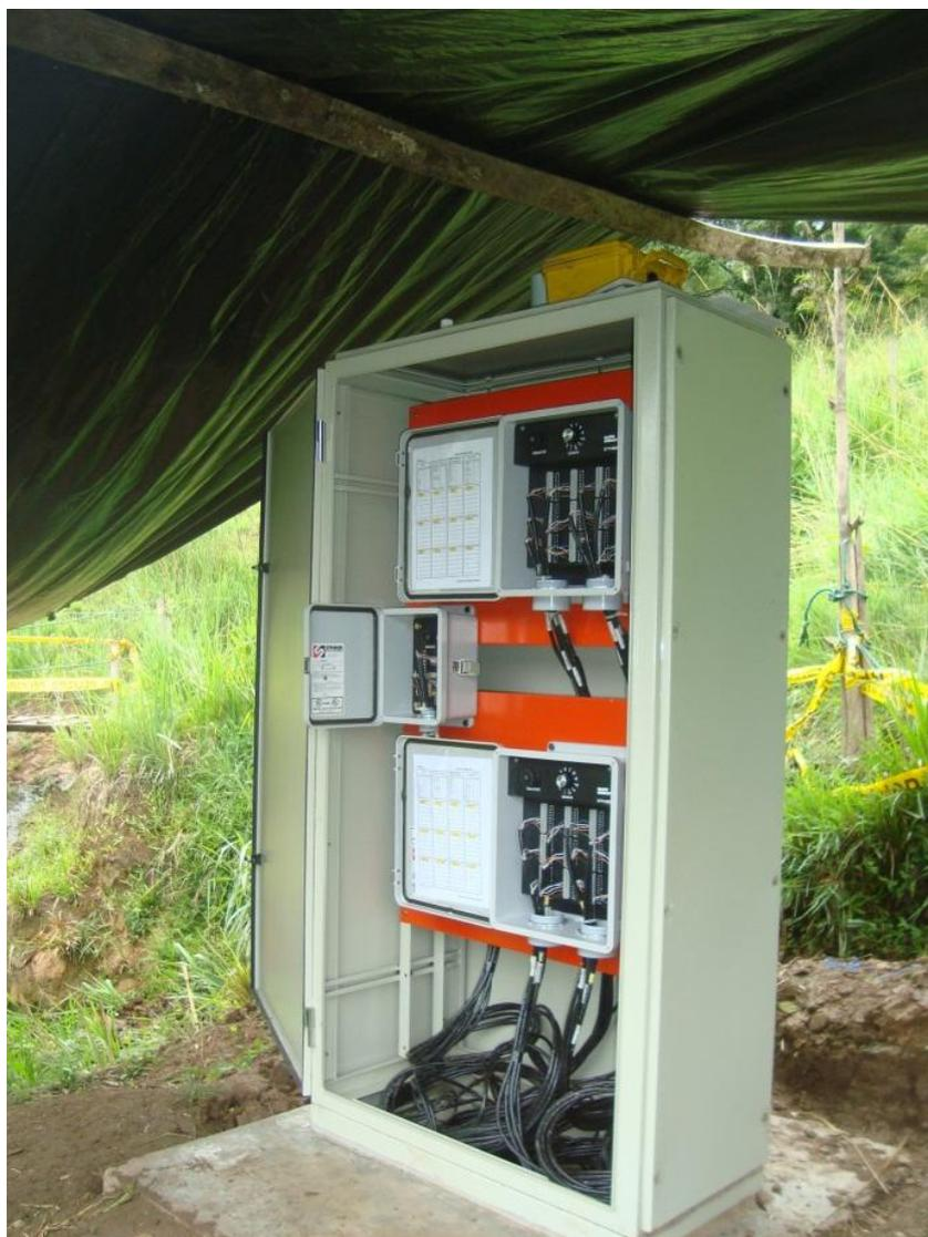
Fig. 21. Colocación del Gabinete de Control
