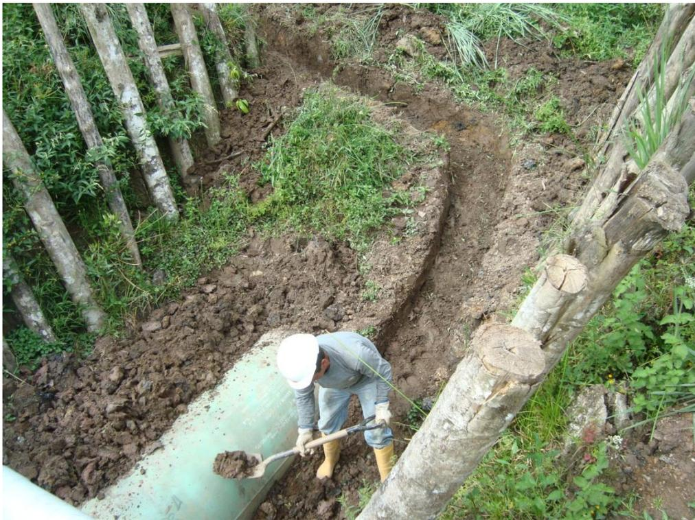
Fig. 19. Construcción de la zanja para el tendido de cable
