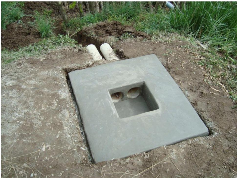
Fig. 20. Construcción de la base para la colocación del Gabinete de Control
