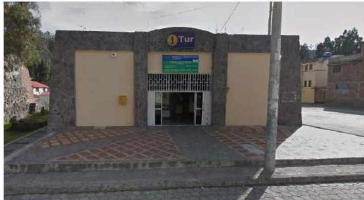
Figura 4-3: Edificio de Turismo del GADM – CG. Fuente: Autores
