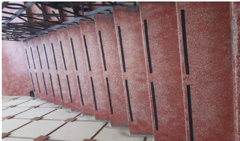
Figura 3-4: Colocación de cinta antideslizante en las gradas del EP.
