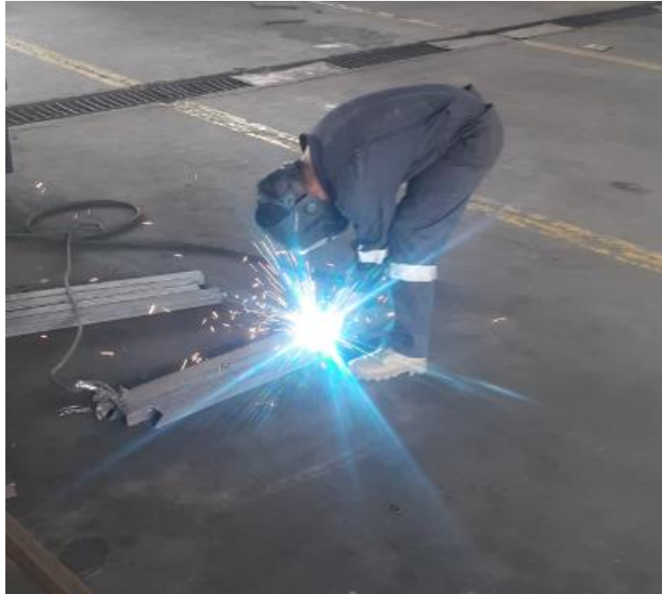
Figura 5-4: Proceso de soldadura MIG de elementos metálicos.
