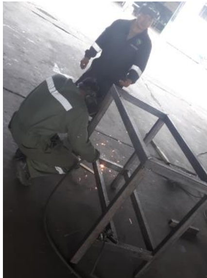
Figura 14-4: Montaje de las columnas de la estructura metálica.
