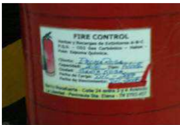
Fig. 99: Extintor tipo PQS-ABC.
