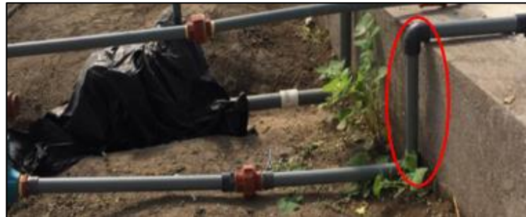
Figura 16-3. Tubería de succión del sistema por gravedad
