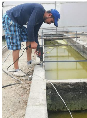
Figura 22-3. Instalación del sistema por gravedad
