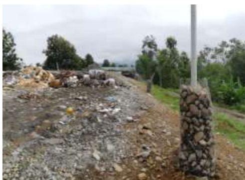
Figura 6-1. Inadecuada distribución de chimeneas.
