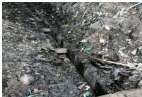
Figura 2-1. Canal de drenaje.
