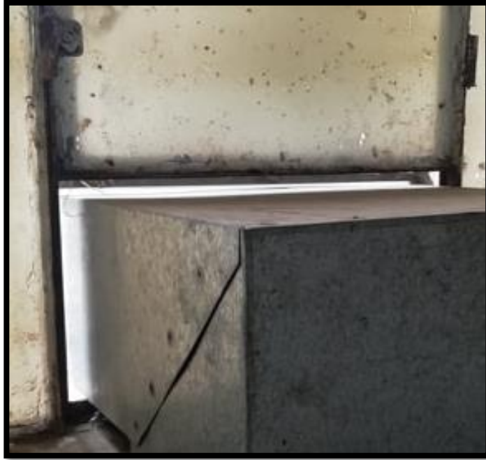
Imagen 7: Presencia de orificios en el área de producción.
