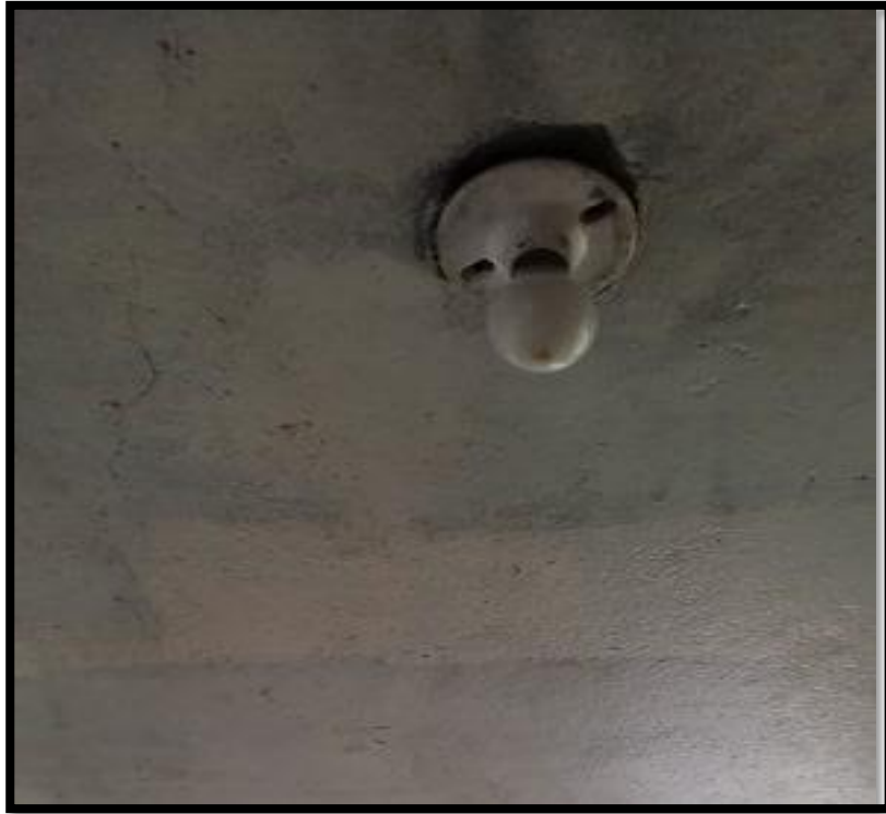
Imagen 3: La iluminación no tiene protecciones.
