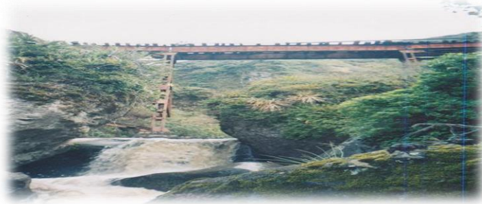
Figura 8-2: Puente San Antonio.
