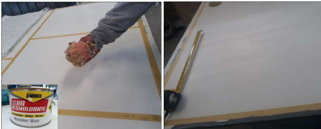
Fotografía 2-3: Preparación e inspección del molde
