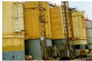
Figura 3. Espuma de Poliuretano rígido como aislante térmico en tanques [7].
