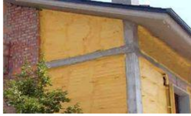
Figura 5. Espuma de Poliuretano rígido como aislante térmico en viviendas [6].
