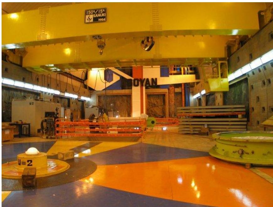
Figura 1. Casa de Máquinas de la Central Agoyán.
