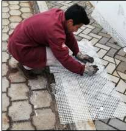
Figura 11-2. Dimensionamiento de la malla de polímero
