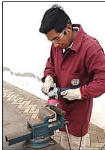
Figura 8-2. Limpieza mecánica de juntas soldadas
