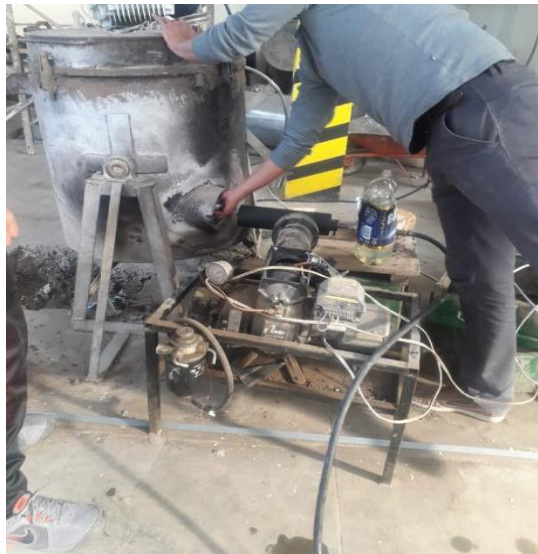
Figura 24-2. Encendido e instalación de quemador en el horno.
