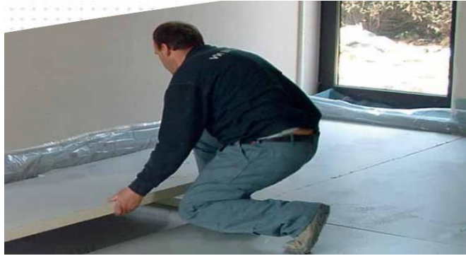
Figura 12-1. Aplicación de planchas para aislar pisos
