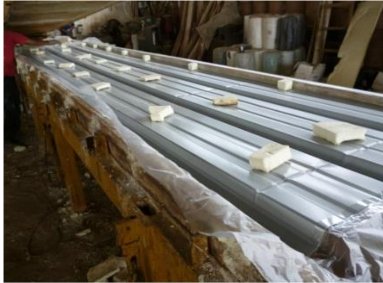
Figura 19-1. Disposición de poliuretano sobre lámina inferior
