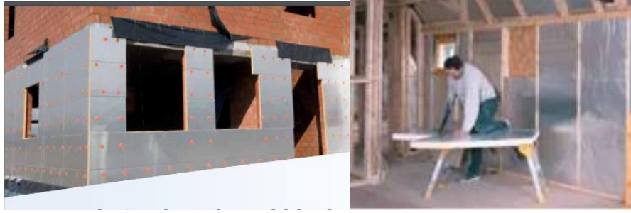
Figura 10-1. Planchas de poliuretano en fachadas internas y externas
