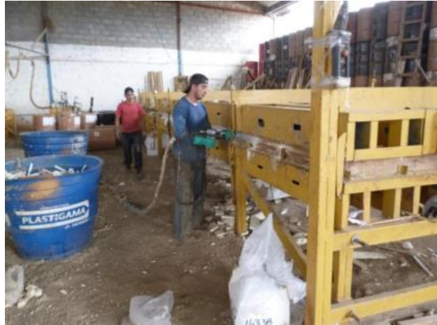
Figura 21-1. Proceso de inyección de la mezcla
