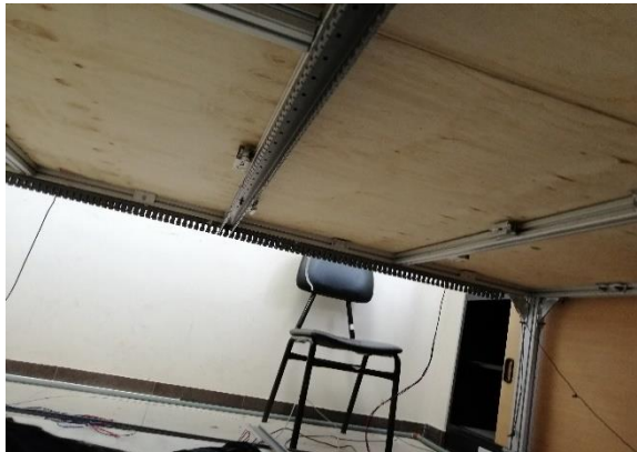
Figura 19-2: Colocación de canaletas para cableado
