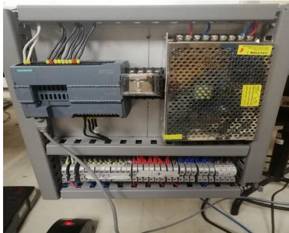
Figura 21-2: Montaje de PLC en Tablero
