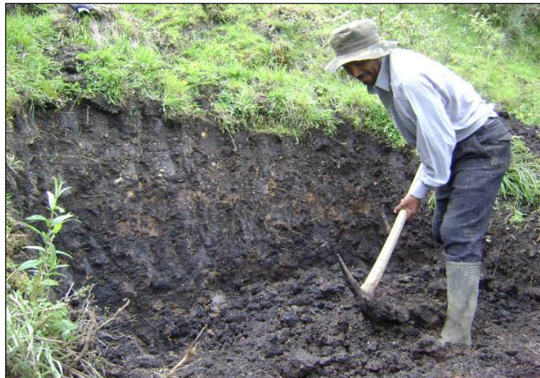
Figura 2.4: Excavación de puntos de revisión
