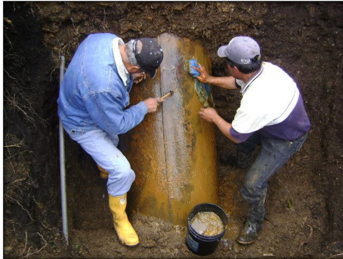
Figura 2.5: Limpieza exterior de la tubería de presión
