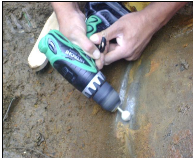
Figura 2.6: Preparación tubería de presión
