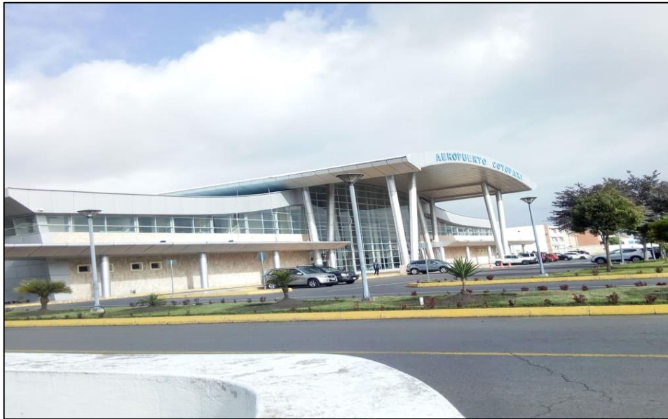
Fotografía 1: Aeropuerto Internacional Cotopaxi, exteriores
