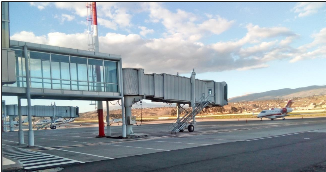
Fotografía 9: Pasarela de acceso a aeronaves
