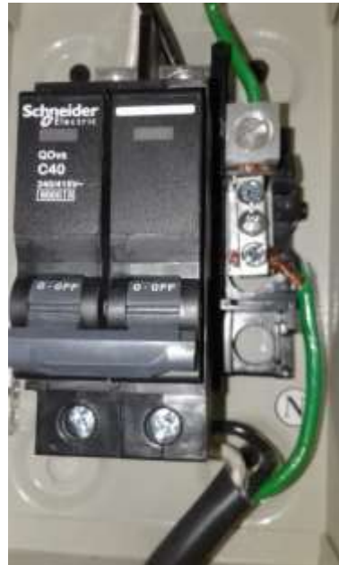
Figura 1 – 3: Levantamiento de las seguridades del circuito ya instaladas.
