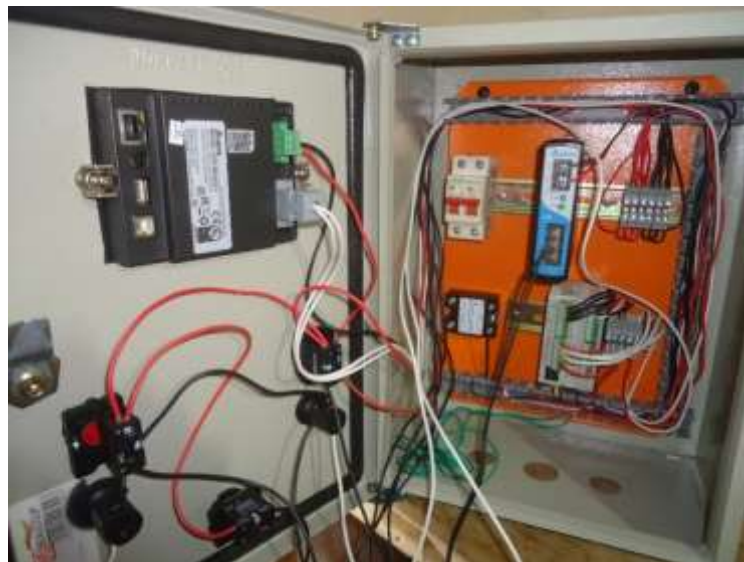
Figura 33 – 2: Implementación del cableado según el diseño. Realizado por: CAISAGUANO, Washington, 2018
