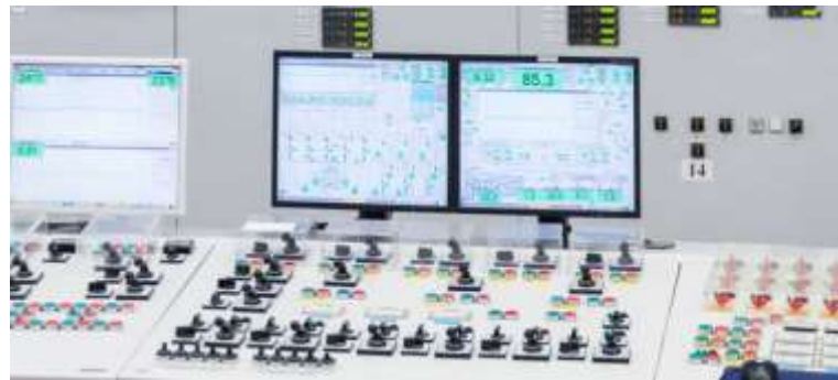
Figura 23 - 1: Sistema Scada basada en computadoras
