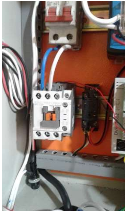
Figura 34 – 2: Conexiones del contactor de 22 A. Realizado por: CAISAGUANO, Washington, 2018
