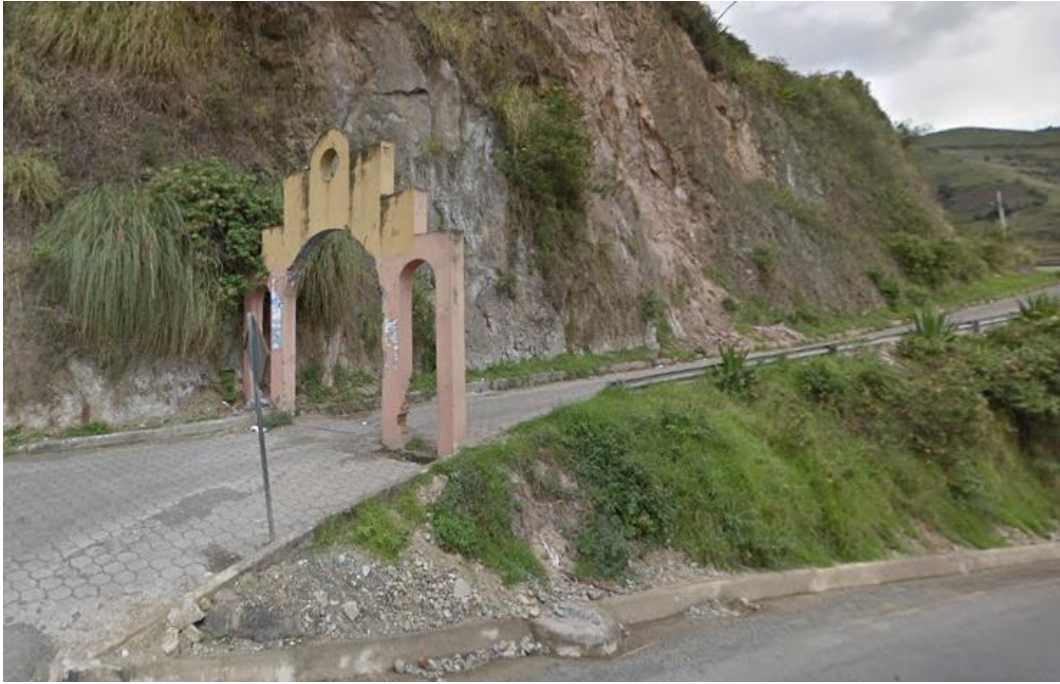
Figura 26-3. Entrada de la vía Tamban
