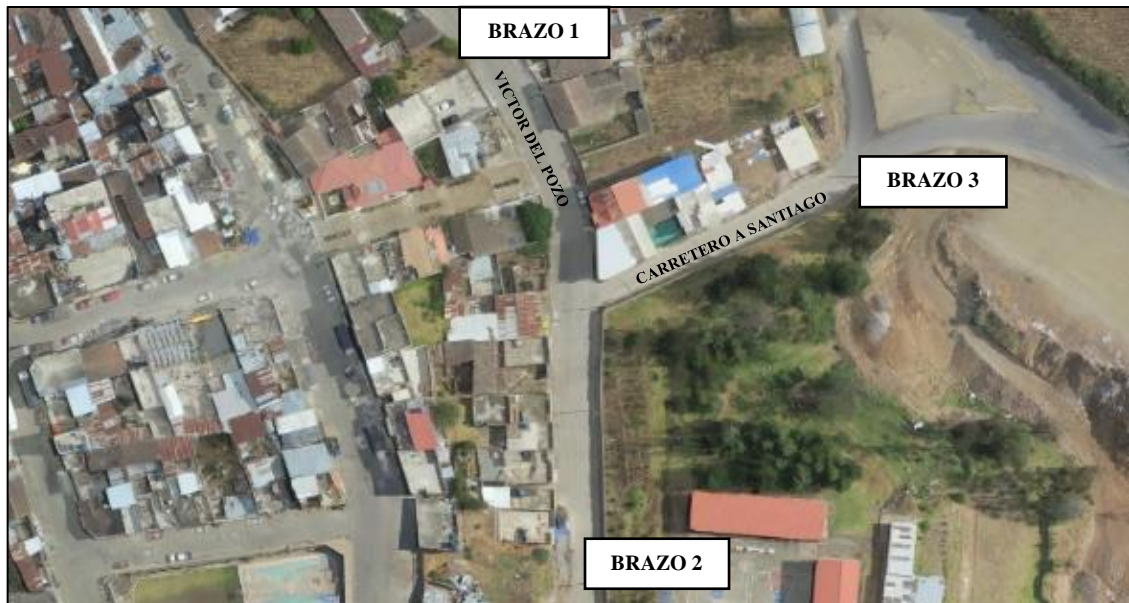
Figura 28-3. Foto de la intersección, Víctor del Pozo y carretero a Santiago
