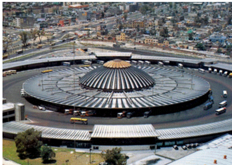
Figura 2-2: Vista del Terminal de Autobuses de Pasajeros de Oriente (TAPO) Fuente: http://fotos.eluniversal.com.mx/coleccion/muestra_fotogaleria.html?idgal=16819 , 2006
