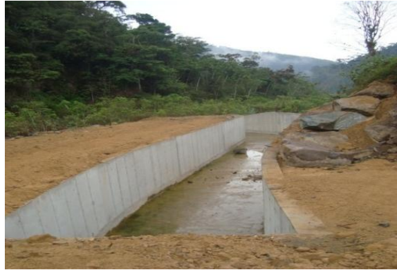
Imagen 7: Canal de evacuación
