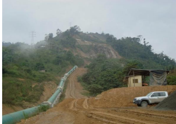
Imagen 5: Tubería de presión
