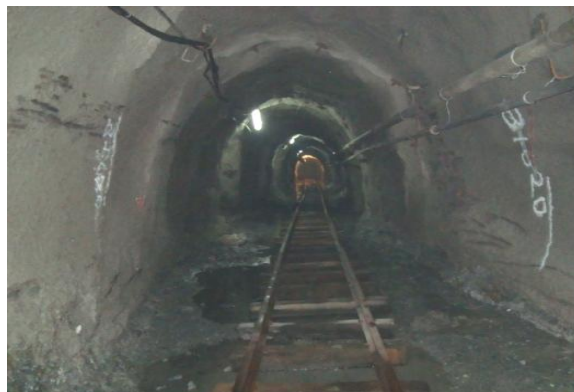
Imagen 3: Túnel de conducción
