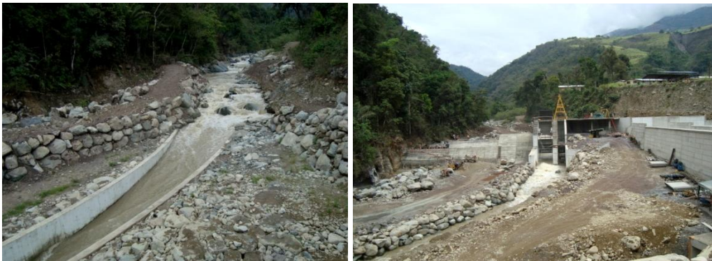
Imagen 1: Obras de captación
