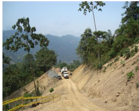
Imagen 9: Apertura de vías de acceso
