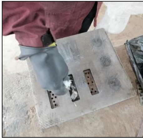
Figura 8-3: Colocación de la mezcla con la fibra de vidrio
