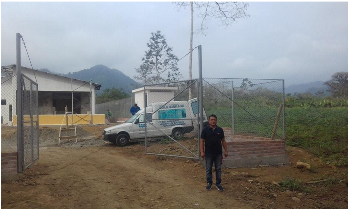
Fotografía 3 Lugar donde se construirá el Centro de faenamiento
