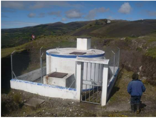
Fotografía 8-1: Tanque de Reserva
