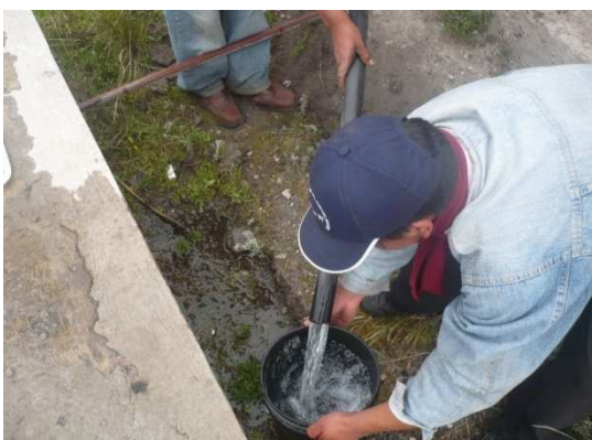
Fotografía 8-7: Red de Distribución
