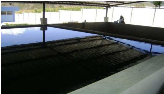
Fotografía 8-68: Tanques de Reserva de Agua
