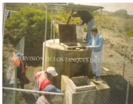
Fotografía 8-31: Supervisión de los tanque de Captación
