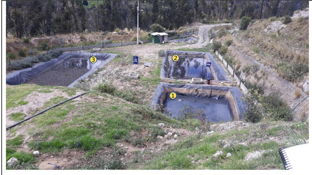
**Fotografía 4-3:** Disposición de lagunas de fitorremediación. 1) Laguna de tormentas, 2) laguna de fitorremediación 2 y 3) Laguna de fitorremediación 1.
