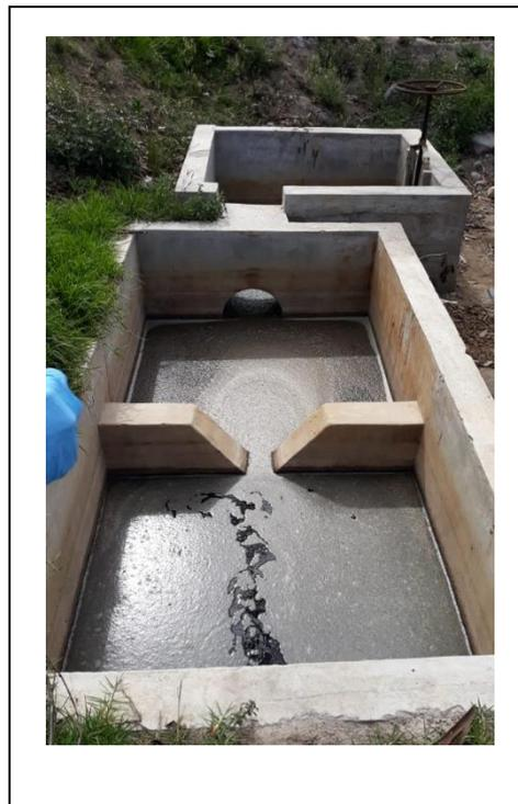
**Fotografía 2-3:** Tanque decantador.
