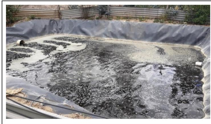
**Fotografía 3-3:** Piscina de aireación, tratamiento biológico del sistema de tratamiento de lixiviados.
