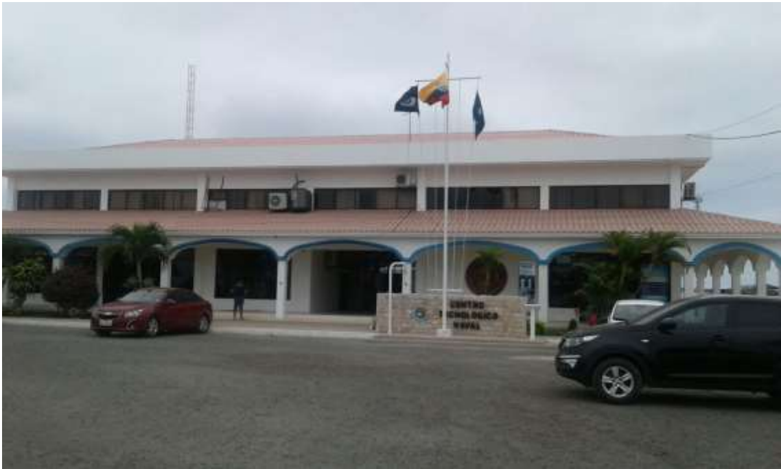
Anexo 8: Infraestructura CETNAV
