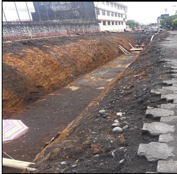
Fotografía 7. Trabajos en la zona urbana de Macas.
