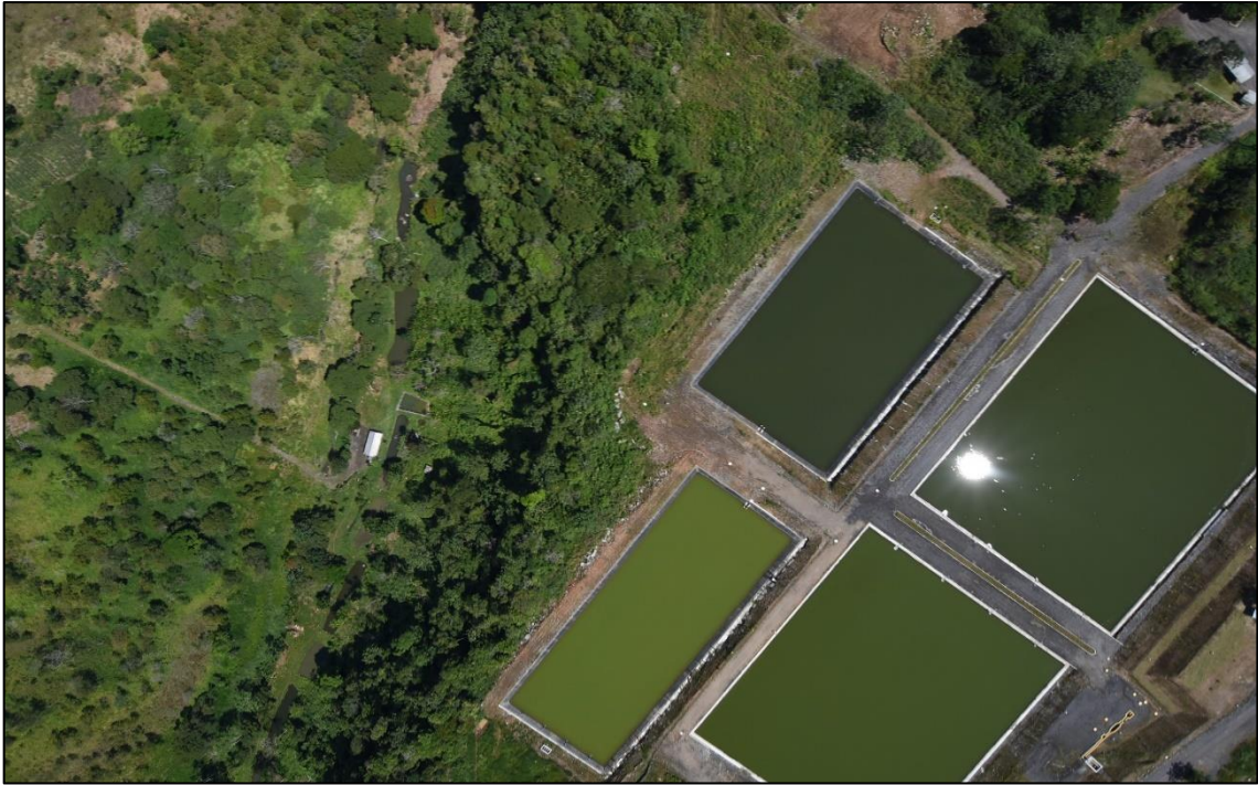
Fotografía 19. Zona Piscinas de oxidación de la parroquia Macas
