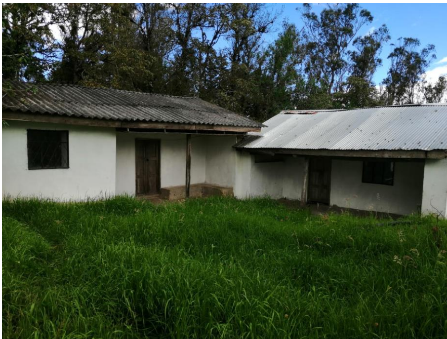
Anexo Fotográfico 4: Vivienda en el asentamiento Llamallún.
