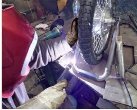
**Figura 15-3: Soldadura de la horquilla.**
