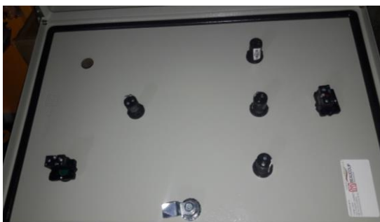
Figura 3-41: Montaje de lámparas. Fuente: Autores, 2019.
