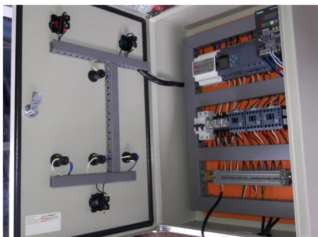
Figura 3-45: Colocación de tapas en las canaletas. Fuente: Autores, 2019.
