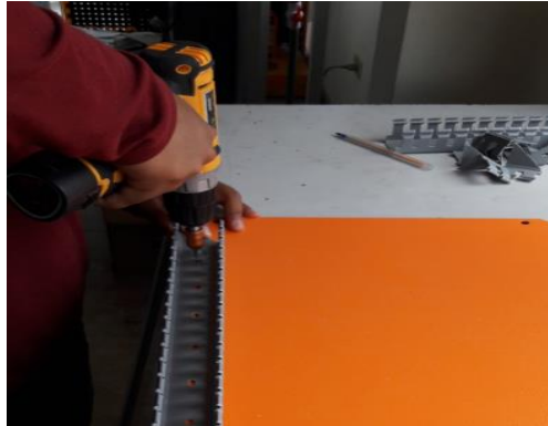
Figura 3-37: Ubicación de canaletas. Fuente: Autores, 2019.
