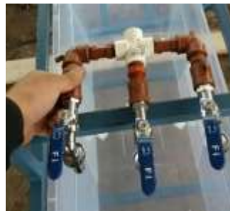
Figura 14-3: Instalación de las tres llaves de agua en la descarga Fuente: Autores
