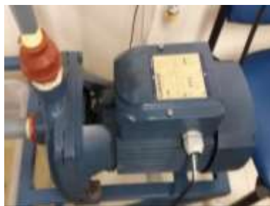
Figura 12-3: Instalación de bushing en succión Fuente: Autores
