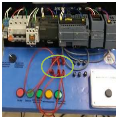
Figura 34-3: Terminales para el circuito de potencia en arranque directo Fuente: Autores
