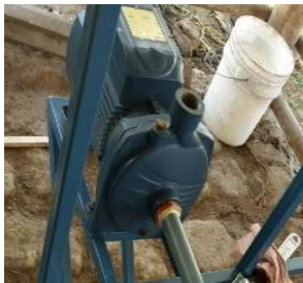
Figura 10-3: Anclaje de la bomba de agua a la estructura Fuente: Autores
