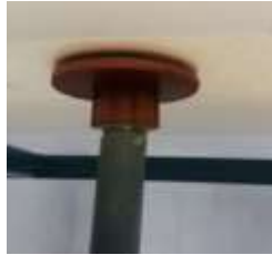
Figura 13-3: Instalación de la salida de estanque en el recipiente superior Fuente: Autores
