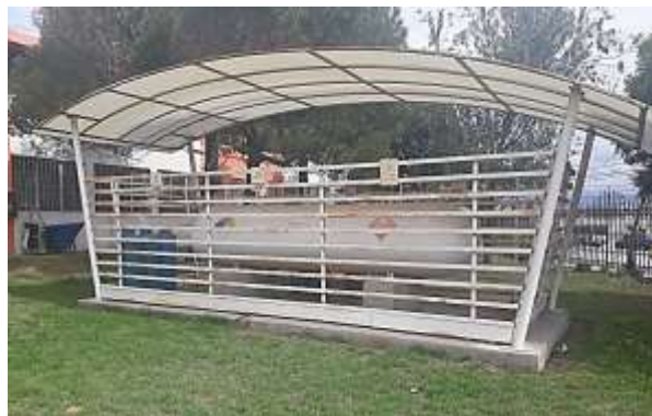
Figura 6-3. Tanque Fuente: Autores
