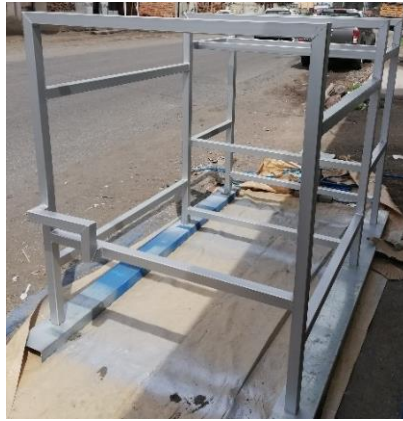
Figura 3-5: Construcción de la Estructura
