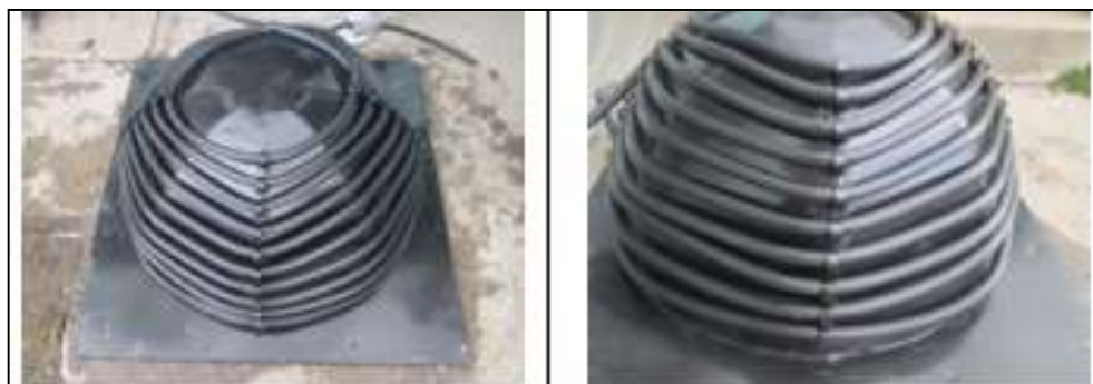
Figura 20-3: Circuito hidráulico, disposición en espiral.
